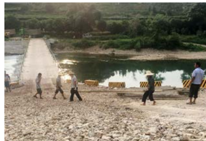
项目施工现场
